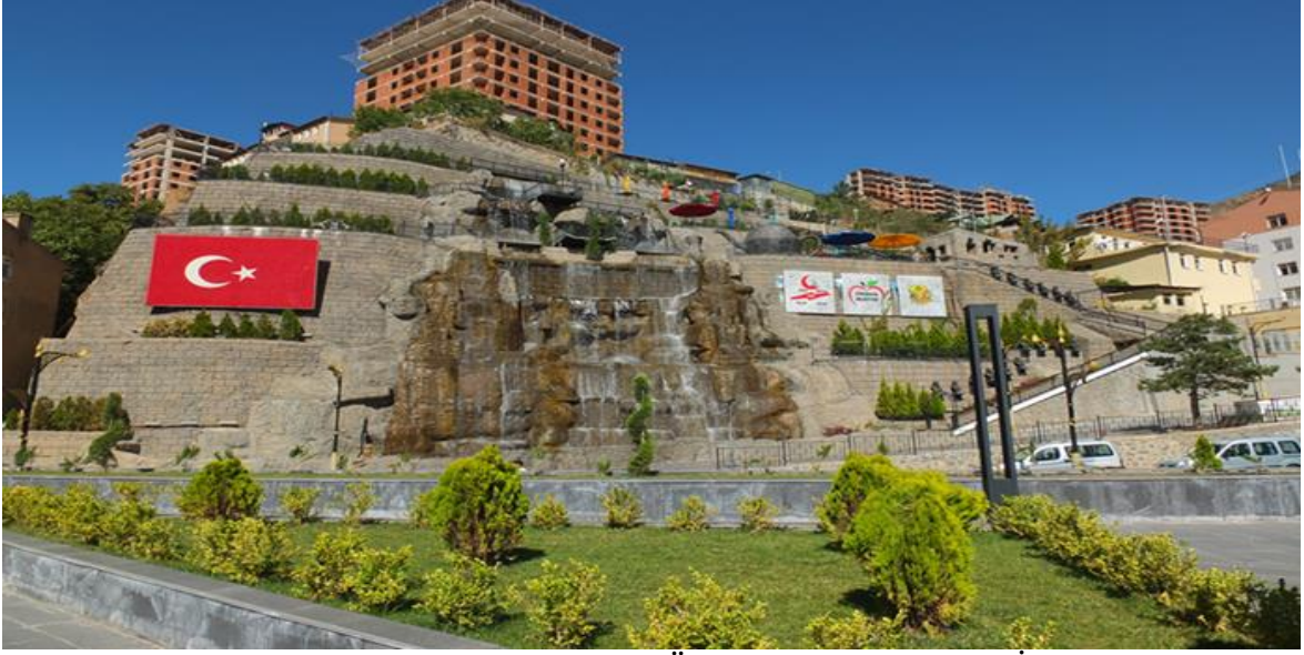
Foto 5: Gümüşhane Kent Merkezinde Kentin Önemli Simgelerinden İstinad Duvarları ve Yapay Şelale- Üstte Modern Yapılara Ait İnşaatlar
