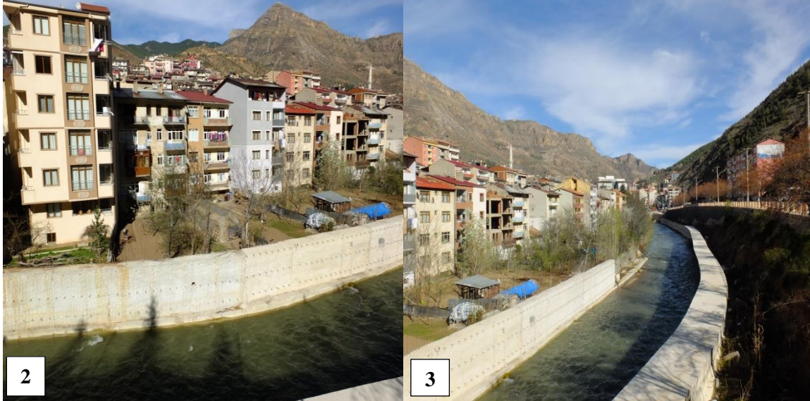
Foto 2: Kent Merkezi ve Harşit Çayından Görünüm
